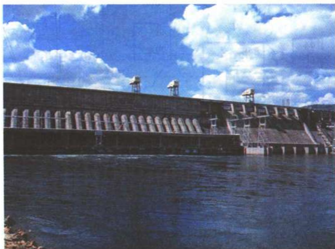
Рис. 43. Плотина Красноярской ГЭС
