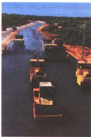
Рис. 61. Строительство автодорожной магистрали
